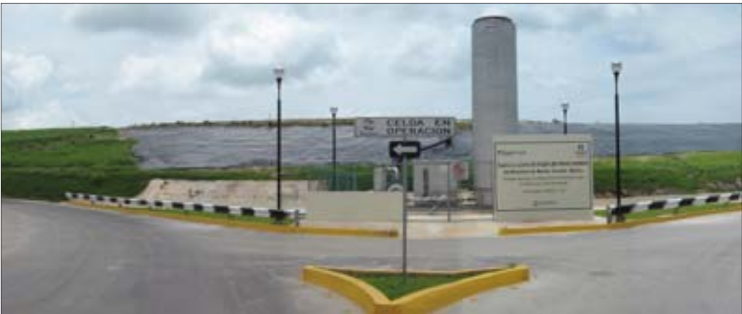
Captura y quema de biogás del relleno sanitario del Municipio de Mérida, Yucatán (México). El proyecto está registrado en el Mecanismo de Desarrollo Limpio en el Marco del Protocolo de Kyoto.
